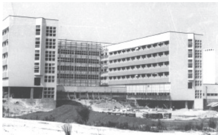
Hospital Nossa Senhora do Rosário - Edifício actual ainda em construção
